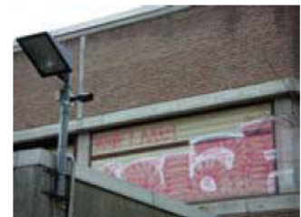
Eine der am Schulzentrum installierten Kameras.
